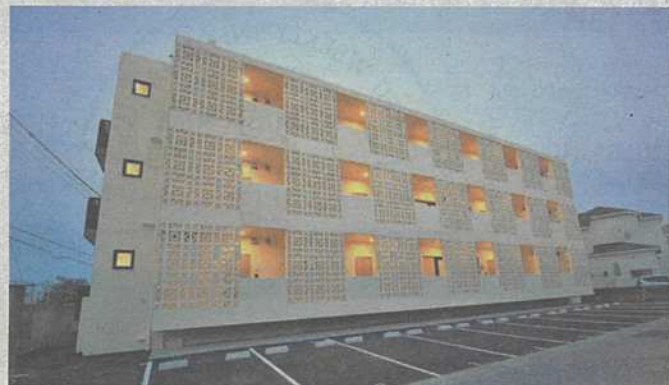
花ブロックから漏れるやわらかな灯りが印象的なファサード
